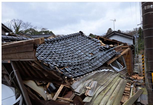
写真2 地震で倒壊された木造住宅
