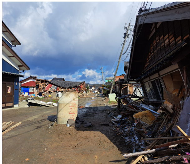
写真9 珠洲市の津波現場・地震によるマンホールの隆起
