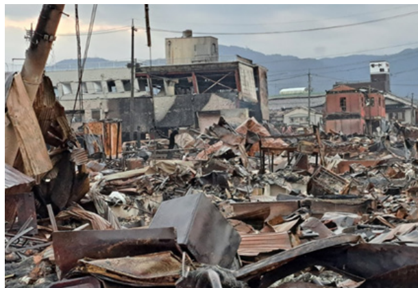
写真4 輪島市の災害現場
