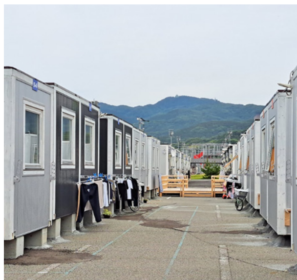
写真13 輪島市内の応急仮設住宅
