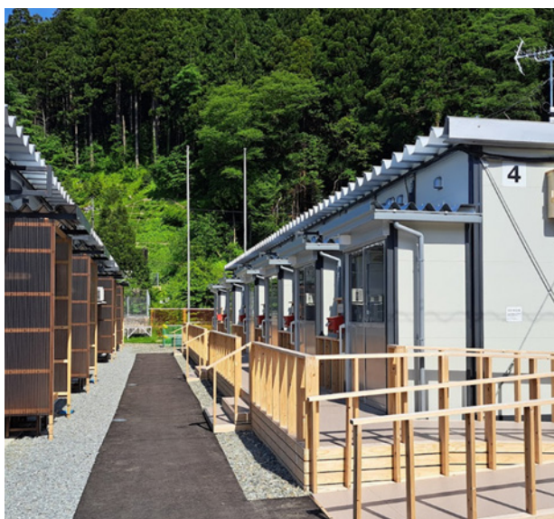
写真12 輪島市内の応急仮設住宅
