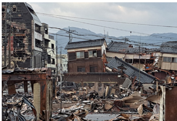
写真1 輪島市朝市大火後の現場
